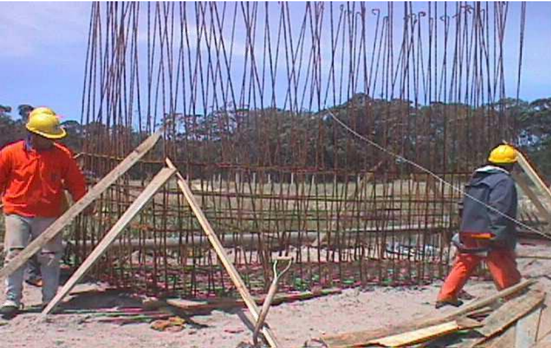
ARMADURA DE HIERRO EN ESTRUCTURA DE HORMIGÓN ARMADO PARA EL POZO DE BOMBEO
