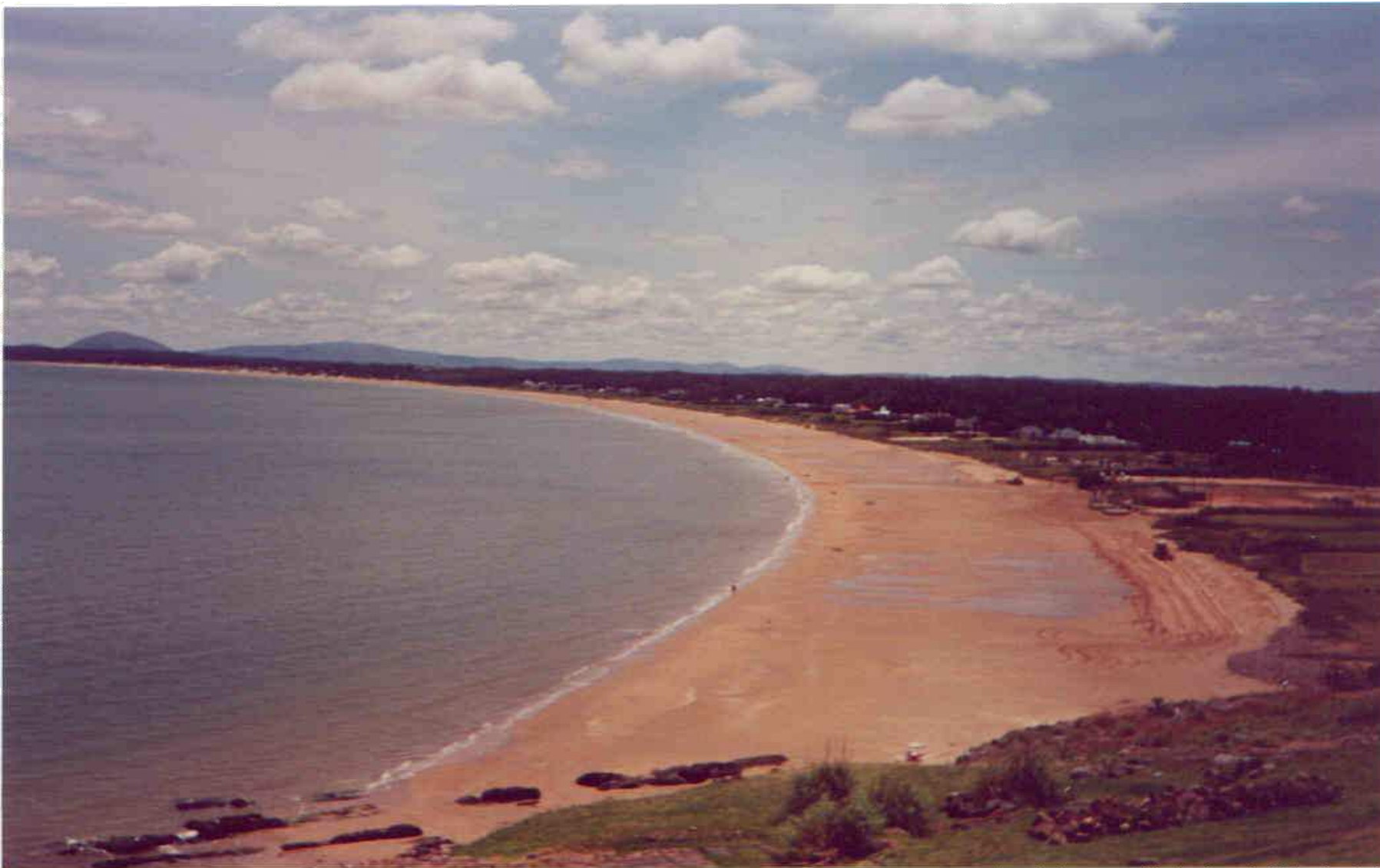
Continuación del agregado de arena, esparciéndola con motoniveladora 2 de diciembre de 2001
